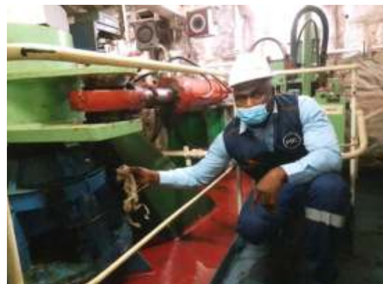
OCNEP CONTROLANT LE BOITIER DE LA NECHE DU GOUVERNAIL DANS LE LOCAL DE L'APPAREIL A GOUVERNER
