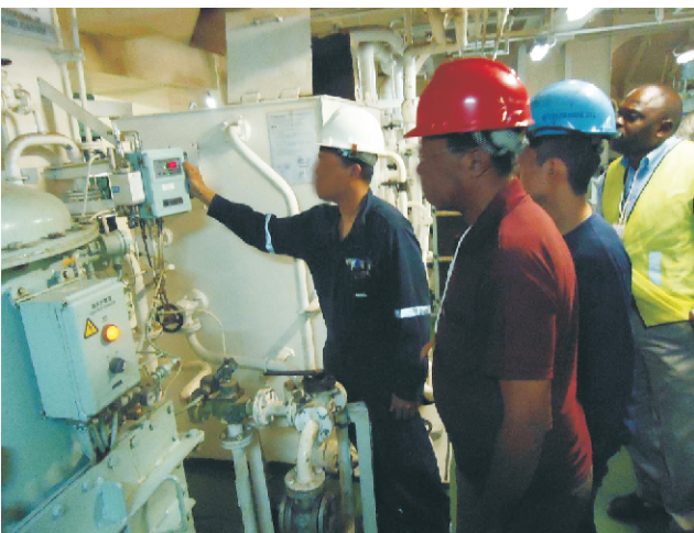
Inspection du CNEP sur le séparateur d'eau huilée, Gambie.
