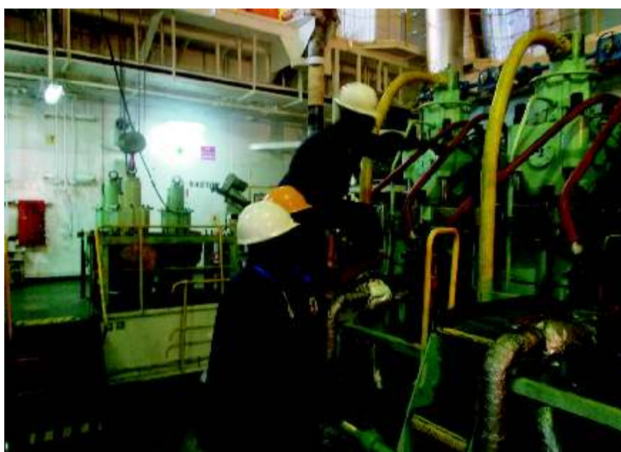
OCNEPs de la Guinée inspectant la Salle des Machines
