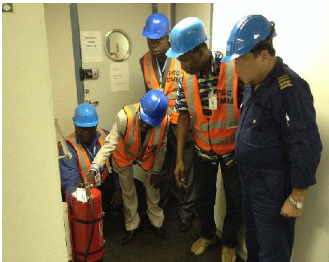
OCNEPs du Bénin vérifiant la date d'expiration de l'extincteur
