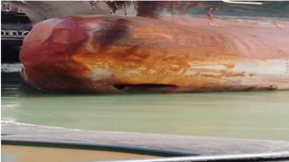
Inspection des Arcs Bulbeux endommagés, rouillés et cassés
