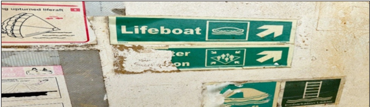
Aft Starboard Deck Side Muster Station and Life Raft Safety Sticker Damaged Autocollant de sécurité du point de rassemblement et du radeau de sauvetage tribord arrière endommagé
