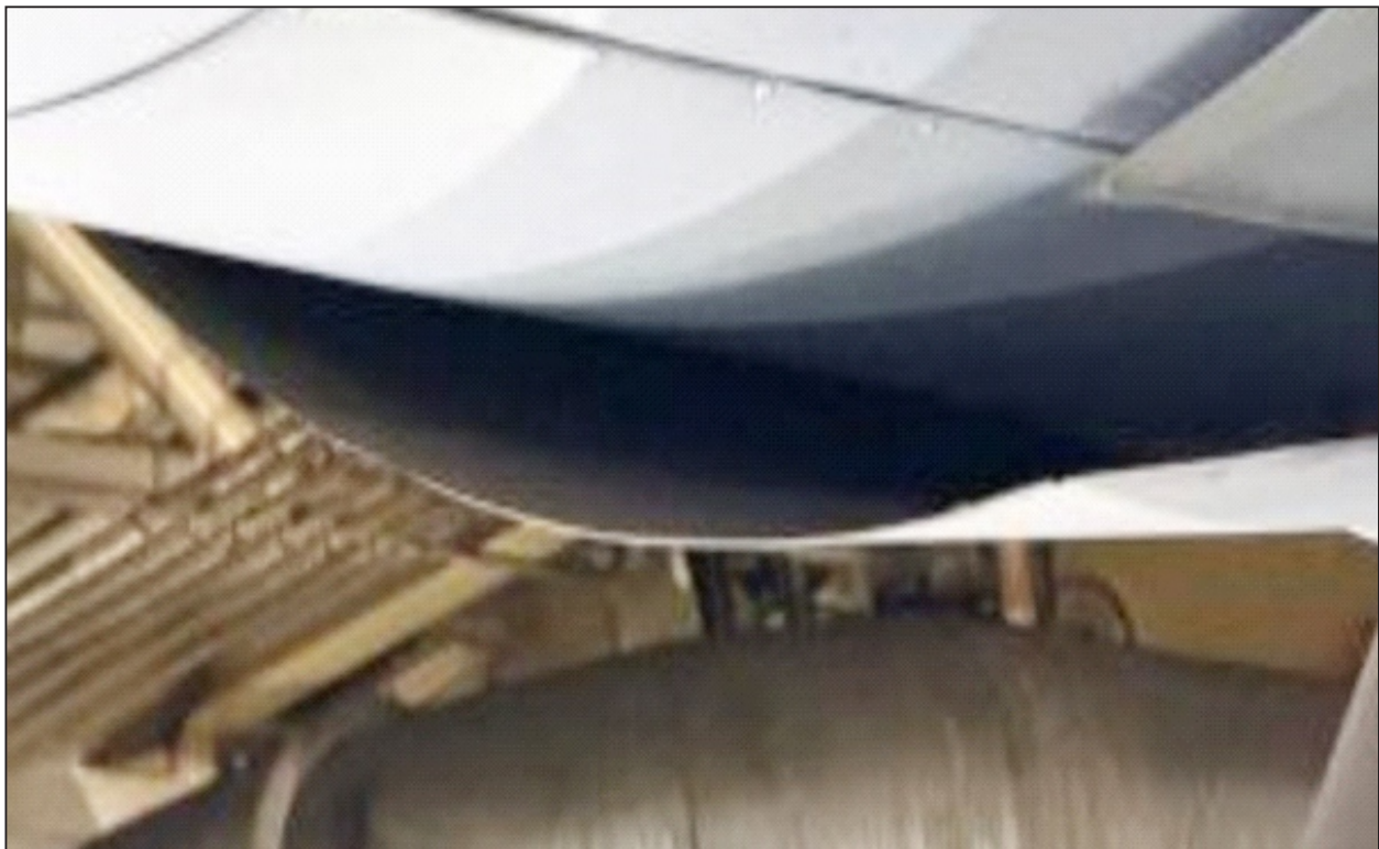
Main Engine Exhaust Insulation Cover to fix back Le Couvercle d'isolant de l'échappement du moteur principal à remettre en place.
