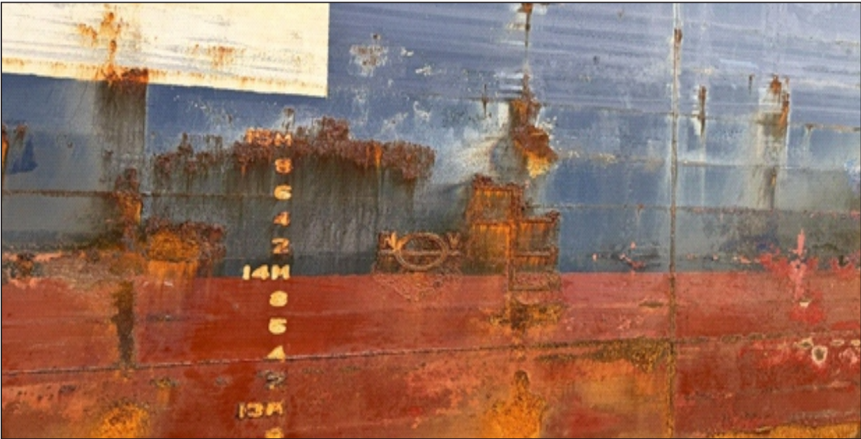
Ship Hull marking and Plimsoll Marking not Visible Marques de coque et ligne de charge du navire invisibles
